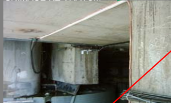
POHYBLIVÝ PŘÍVOD MAZIVA A KABELU BEZKONTAKTNÍHO SNÍMAČE KE VRATŮM
