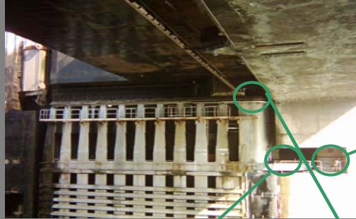
POHYBLIVÝ PŘÍVOD MAZIVA A KABELU BEZKONTAKTNÍHO SNÍMAČE KE VRATŮM
