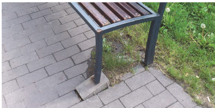
Obr. 3.9 Příklad problémového kotvení předních noh prvku pouze do dlažby (zadní nohy jsou kotveny do zabetonovaného obrubníku).
